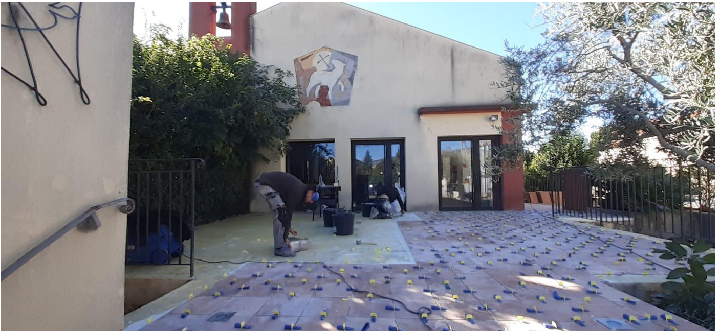
Une entreprise spécialisée est venue ensuite rectifier le support et poser le nouveau carrelage
