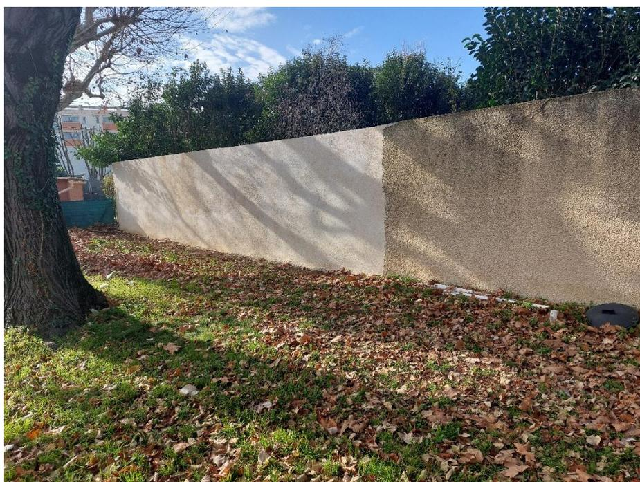
Le mur de clôture en parpaing brut a été enduit. Avec le temps les tons vont s'harmoniser
